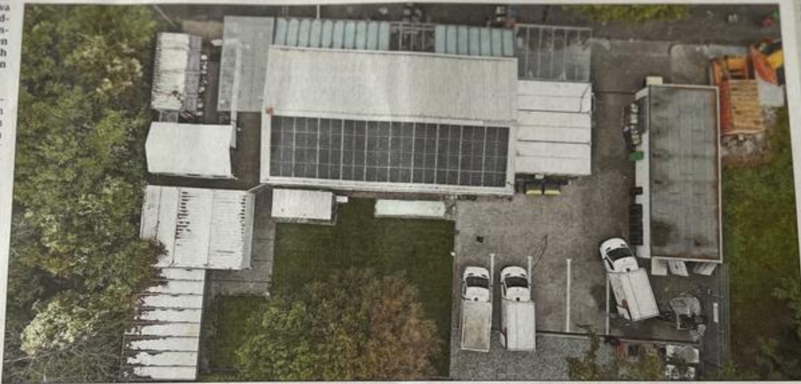
Die Anlage auf dem Dach der Tafelzentrale in West aus der Vogelperspektive. Sie kostete 40.000 Euro.
