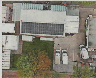
Die neue Photovoltaikanlage der Tafel
